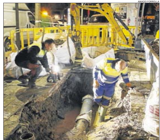
Operarios trabajando en la reparación de la avería.
